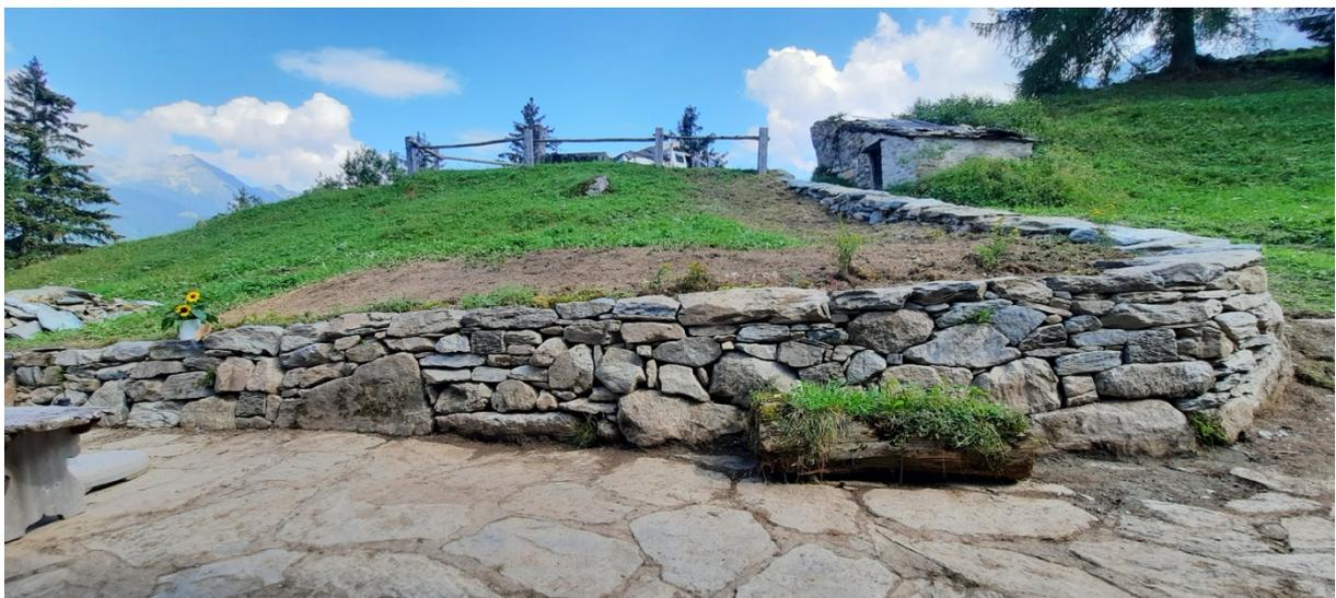
Neubau einer Trockenmauer mit fliegender Treppe (Glarnerland)
