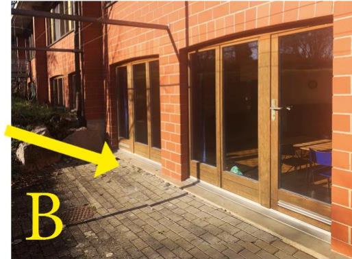
Bodenplatten bis zum Haus
